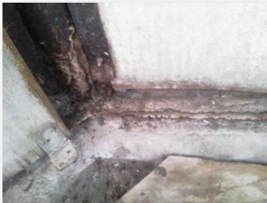
老朽化し、錆びた鉄骨と浸水の形跡
