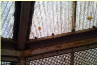
屋根の老朽化による雨漏りや錆びによる浸水に注意
