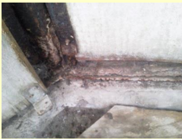
屋根の老朽化による雨漏りや錆びによる浸水に注意
